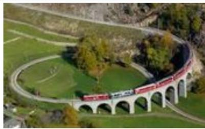
Dopo pochi chilometri dalla partenza, in territorio svizzero, il trenino supera il **Viadotto elicoidale di Brusio**, simbolo della tratta ferroviaria. Il viadotto elicoidale, un vero gioiello architettonico e ingegneristico, è stato realizzato per permettere al treno di superare il dislivello, allungandone il percorso, unica alternativa possibile alla cremagliera.
